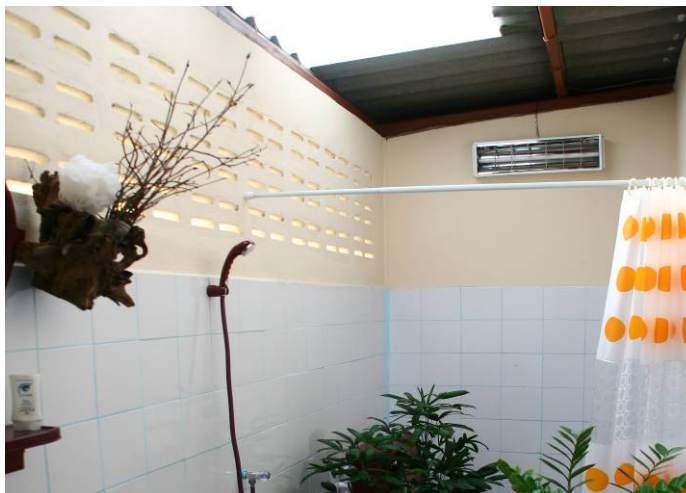
รูปที่ 4.12 ระเบียงหลังคาแบบใสบริเวณห้องน้ำ
