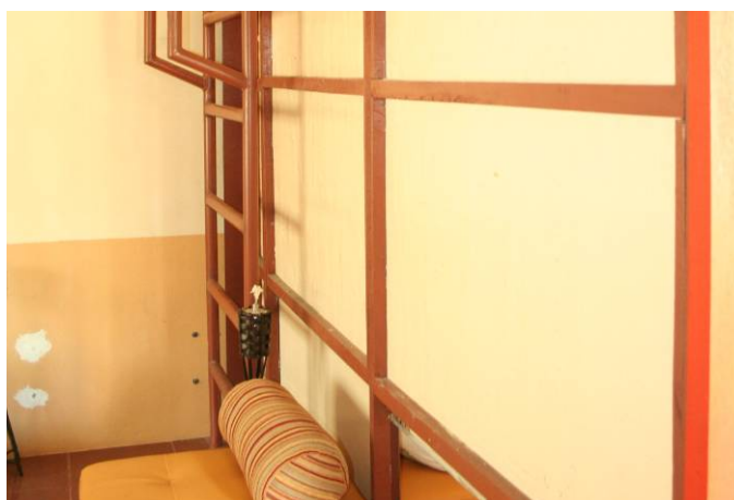
รูปที่ 4.7 แผ่นผนังไม้อัดจากขี้ข้าวโพดสำหรับแบ่งพื้นที่ภายในอาคาร
