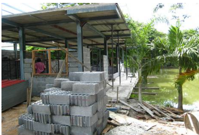
รูปที่ 4.3 คอนกรีตบล็อกผสมน้ำยางธรรมชาติสำหรับใช้ก่อผนังอาคาร
