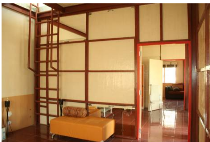
รูปที่ 4.9 ผนังเลื่อนขึ้น-ลงเพื่อถ่ายเทอากาศภายในอาคาร
