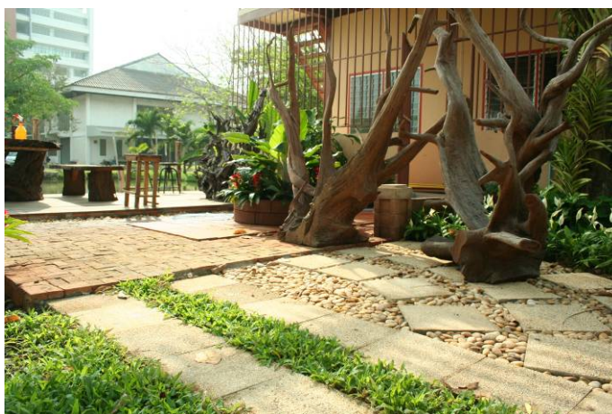
รูปที่ 4.6 บล็อกปูพื้นลดอุณหภูมิภายนอกอาคารสำหรับปูพื้นรอบๆ อาคาร
