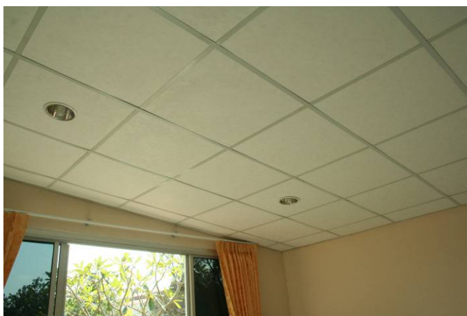
รูปที่ 4.5 แผ่นฝ้าเพดานยิปซัมผสมน้ำยางธรรมชาติสำหรับใช้ตกแต่งอาคาร
