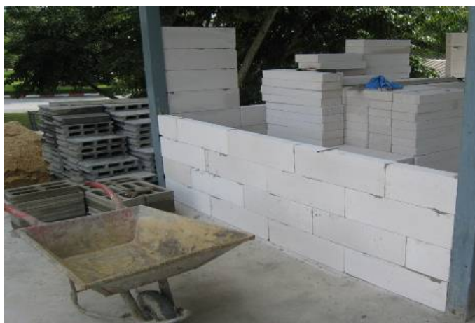
รูปที่ 4.4 คอนกรีตมวลเบาผสมน้ำยางธรรมชาติสำหรับใช้ก่อผนังอาคาร
